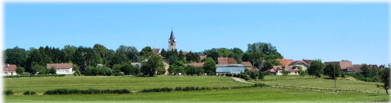
Vue sur Montain
