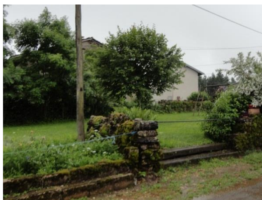
Mur en pierres intra-urbain Source TOPOS
