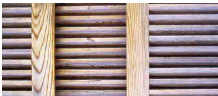
Bois posé à claire voie
