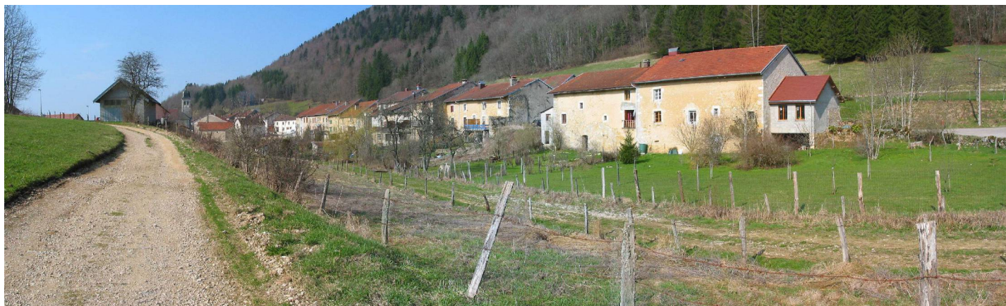
11. Le front bâti de Leschères, vue du Chemin du Fresnois
