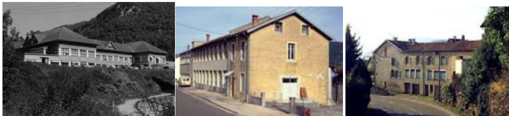
Patrimoine témoin de « l'industrialisation douce » du territoire
