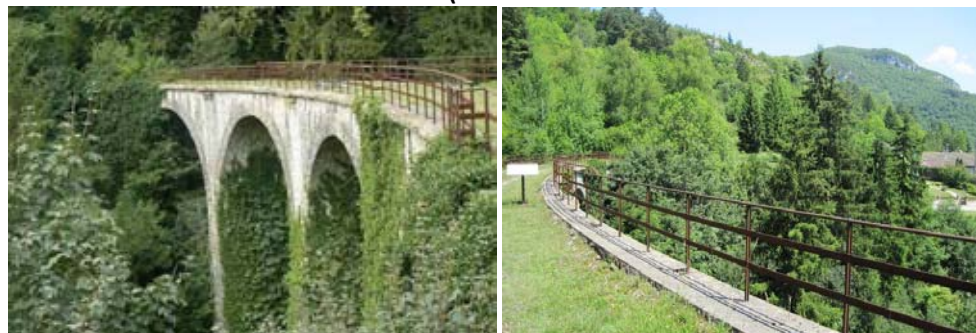
Viaduc du Nans (Lavans-lès-Saint-Claude)
