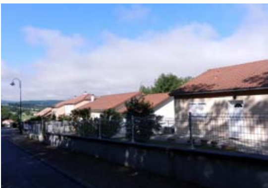
Lotissement du Vieillard
