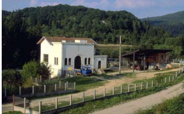
L'ancien Moulin Vuitton : actuelle centrale hydroélectrique
