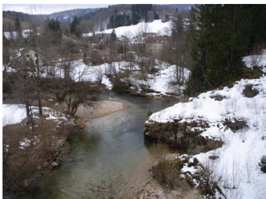
La Saine depuis viaduc des Douanets
