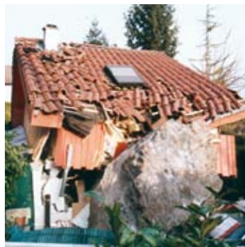
↖ Chute de blocs depuis le versant est du massif de la Chartreuse, le 2 janvier 2002.
