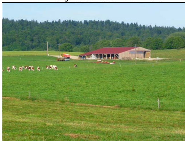
Bâtiment agricole situé sur la commune
