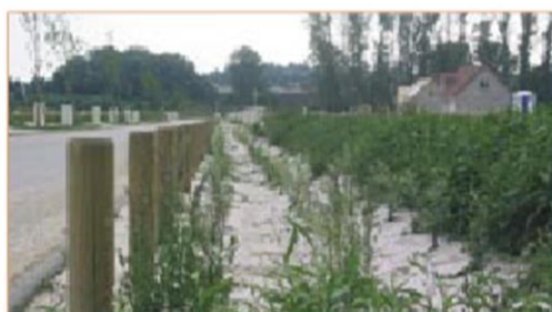
Une noue collectrice des eaux pluviales.
