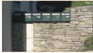
Boîtes aux lettres et coffrets de réseaux peuvent être intégrés aux murets ou à des éléments de clôture.
