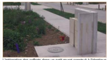
L'intégration des coffrets dans un petit muret construit à l'identique sur l'ensemble de l'opération permet d'en réduire l'impact.
