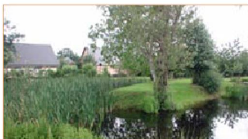
Un bassin filtrant collecte les eaux pluviales et participe à la qualité paysagère.
