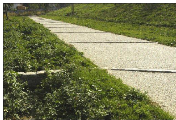
Allée piétonne et sa noue latérale
