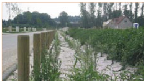
Une noue collectrice des eaux pluviales.
