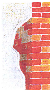
mur ancien en briques enduit au plâtre ou chaux
