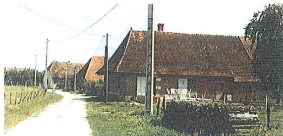
COSGES bâtiments bas parallèles implantés perpendiculairement aux voies.
