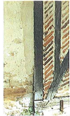
Le pan de bois avec remplissage de briques
