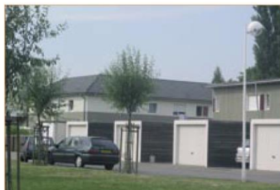
Les garages alignés le long de la rue structurent le front bâti.
