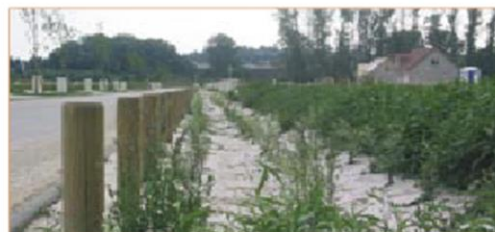
Une noue collectrice des eaux pluviales.
