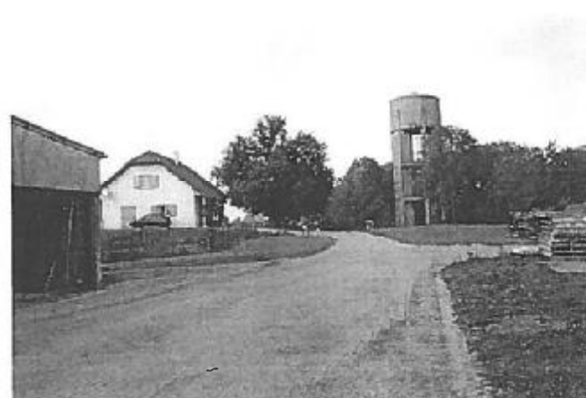
23. Le château d'eau marque fortement le paysage sur la partie Nord du village.
