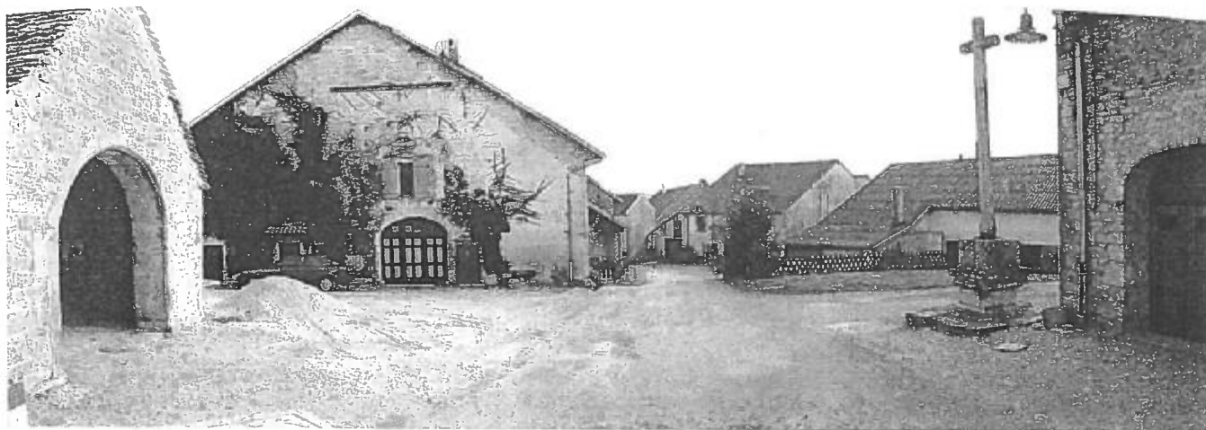
23. Le bâti du village est constitué de nombreuses constructions d'architecture traditionnelle, de grande qualité.
