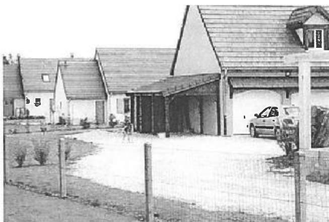
15. Constructions récentes le long de la Rue des Clos (VC1).
