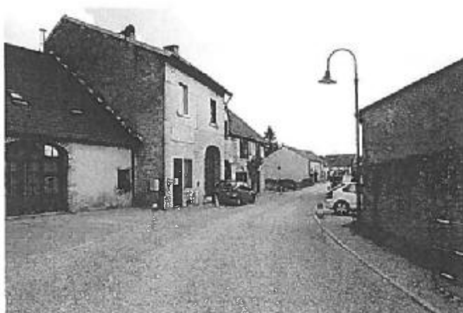
26. La Rue du Chalet en travaux
