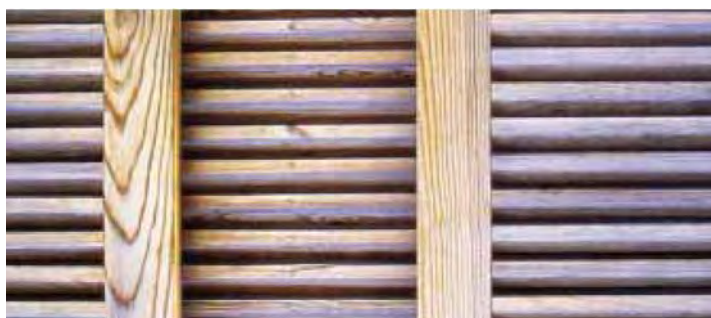
Bois posé à claire voie
