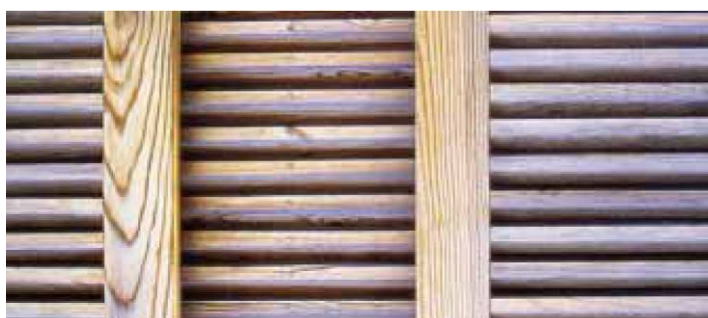
Bois posé à claire voie
