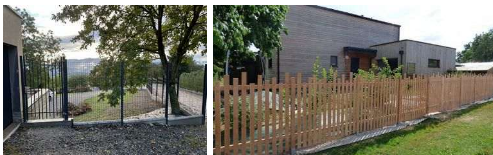
Figure 44. Clôture en métal et en bois
