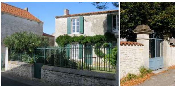
Figure 50. Muret de pierres et murs existants de qualité
