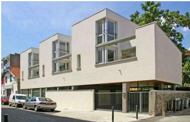
Figure 7. Stationnement en RDC - Grenoble
