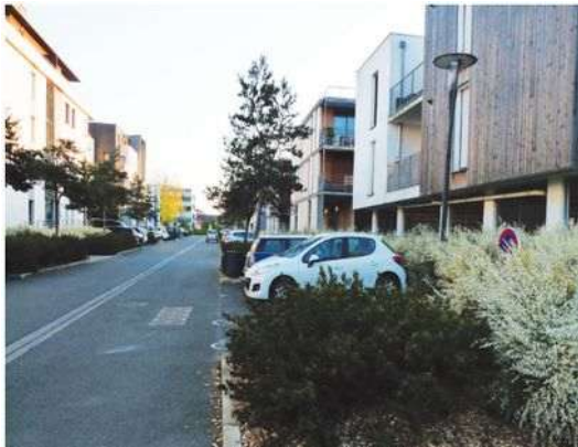
Figure 10 - Gestion de l'interface par le stationnement qui occupe également le rez-de-chaussée – Angers.
