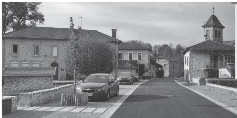
• Atelier du Rouget - Lacapelle del fraisse - travail du sol, du cheminement piéton, parking voiture intégré
