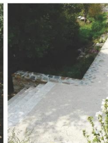
• Mur de soutènement en pierre
