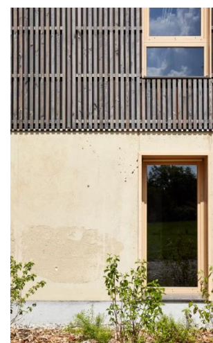
Pépinière d'entreprises "Le Cap" : Construction en béton d'argile coulé et bois ZAC de la Corderie - St-Clair-de-la-Tour Architecte : Reach&Scharff / ©Kévin Dolmaire
