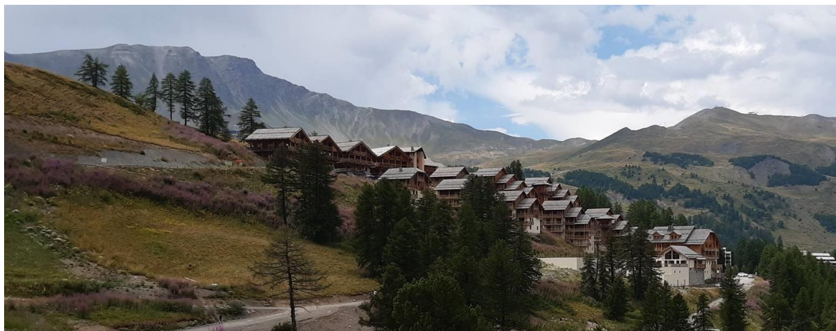
Exemple de typologie de logements collectifs à Vars
