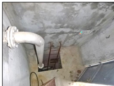
Accès au niveau -1
