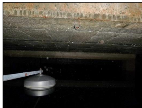
Robinet à flotteur sur l'adduction
