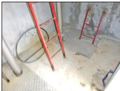
Radier de la chambre des vannes
