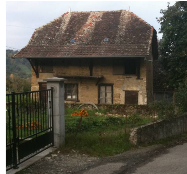
Pisé sous toiture à 2 pans + croupes et coyaux
