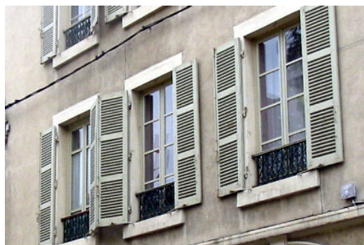
Fenêtres rue Vimaine. Partition à 4 carreaux, garde corps en fonte moulée, persiennes.
