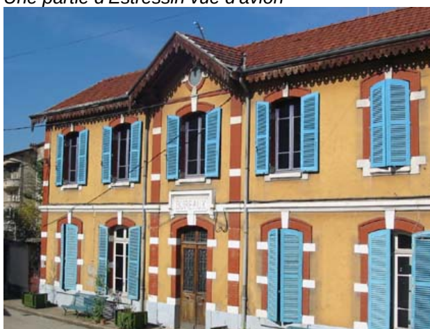
Usine Bechevienne, bureaux.
