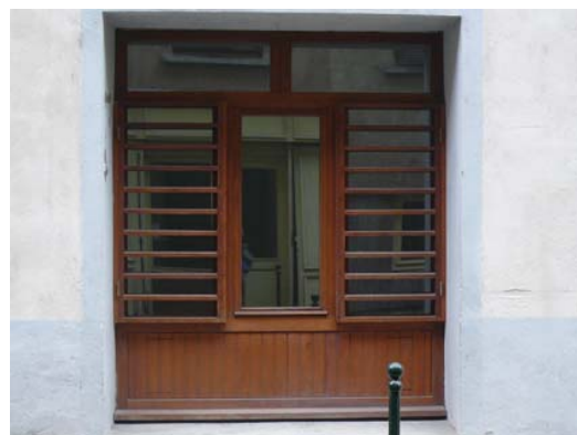
Rez de chaussée transformé en logement, Grenoble
