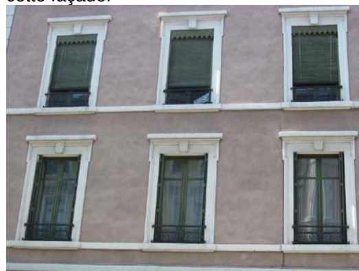
Pour les châssis les tons gris clair ou beige qui se fondent dans le vitrage conviennent. Toutefois pour les fenêtres XIX e qui n'ont pas de volets battants une teinte des menuiseries plus colorée, à l'image de cet immeuble convient également.
