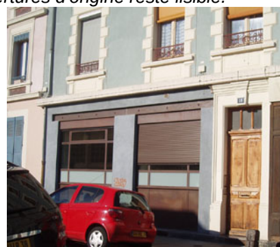
Bonne adaptation d'un atelier en logement
