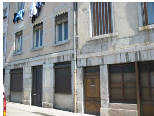
Anciennes boutiques fermées. La forme des ouvertures d'origine reste lisible.
