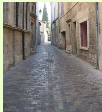
Pavés rejointoyés avec caniveau central
