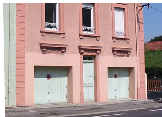
Eviter. Les ouvertures d'origine (il reste les consoles et les chambranles moulurés) ont été transformées pour installer des garages.
