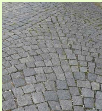
Pavés de granit posés sur lit de sable et jointoyés au sable (Turin, Italie)
