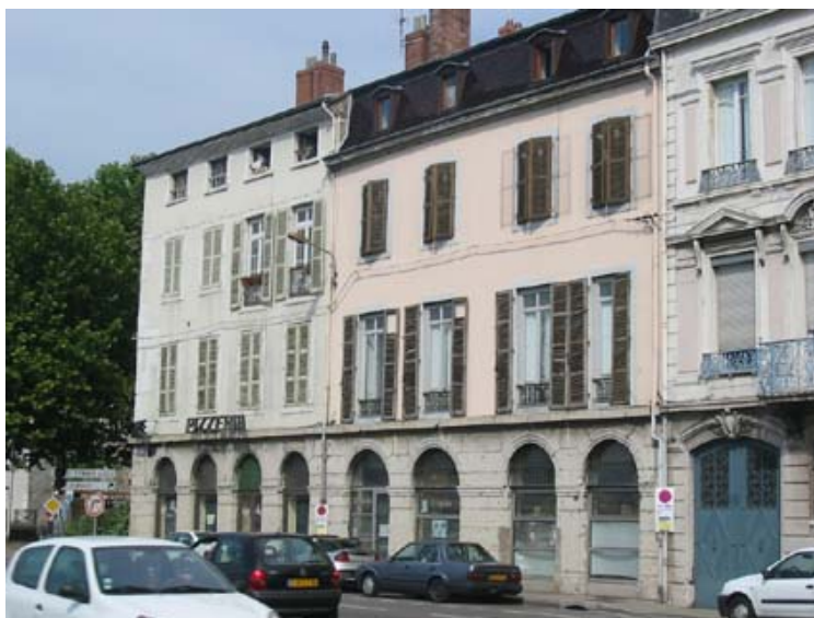
Façades composées, avec soubassement différencié
