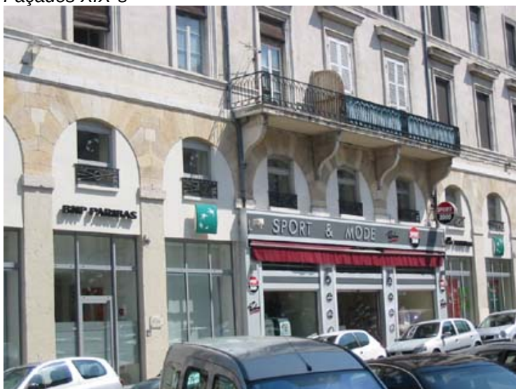
Certains aménagements de rez de chaussée contrarient la composition globale de la façade.
