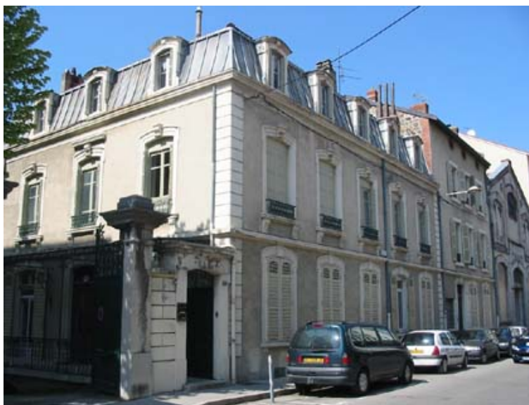
Alignements rue Vimaine. Le respect d'une loi commune d'alignement et de gabarits assure l'unité sur la rue.
