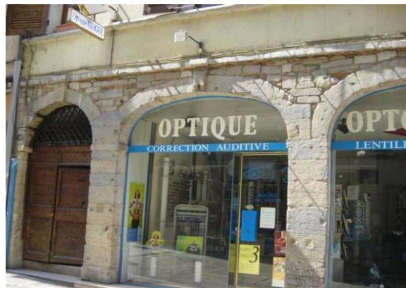
Arc surbaissé et anse de panier (30, rue Marchande)
