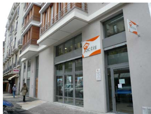
L'enseigne de cette façade devrait être située à l'intérieur de la baie commerciale et non sur le trumeau comme ici. Grenoble
