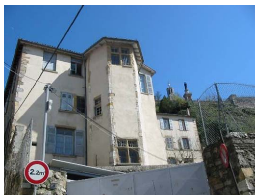
Maison avec escalier hors œuvre (Rue Pipet)
