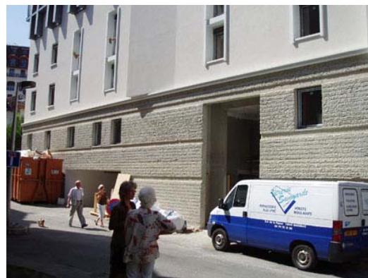
Immeuble récent Aix les Bains. Soubassement en béton architecturé.
