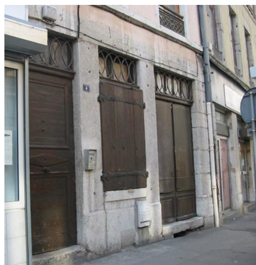
rue de la Gère. On trouve le long de la Gère des soubassements en pierres de taille, plus rarement des façades entières.
