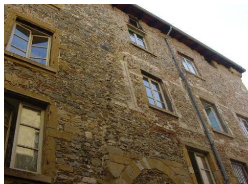
Maison médiévale remaniée, les vestiges des ouvertures d'origine sont encore visibles (Rue des Clercs)
