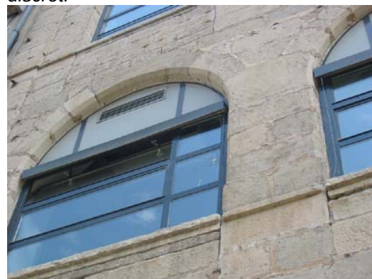
Fenêtres de l'usine Vaganay. La teinte sombre qui se fond dans le vitrage assure une bonne intégration.
