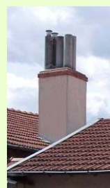
Souche maçonnée et enduite
