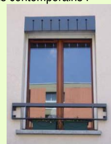
Ensemble lambrequin et garde-corps contemporains
