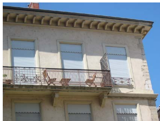
Un exemple de passée de toit à conserver (abouts de chevrons apparents sculptés)
