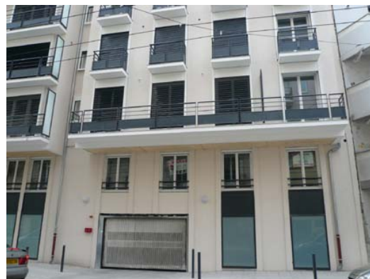
Grenoble, immeuble récent, entrée de garage
