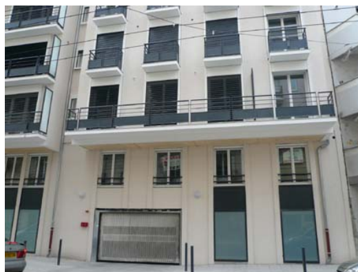
Accès au garage, immeuble récent (en cours de finition) Grenoble
