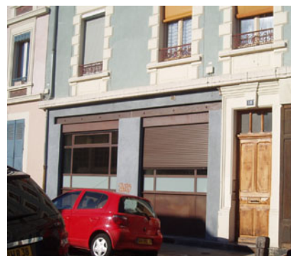
Bonne adaptation d'un atelier en logement
