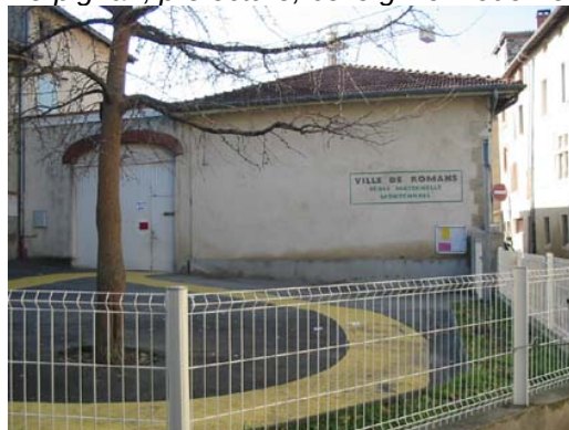
Exemple de grille industrielle interdite
