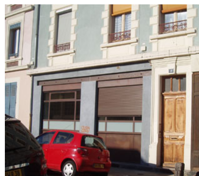
Bonne adaptation d'un atelier en logement
