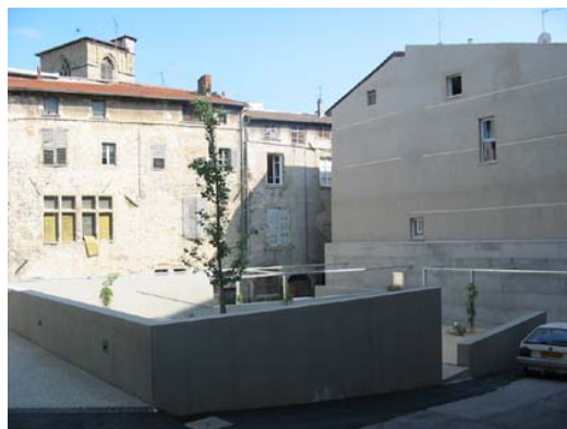
Romans, RHI îlot Folquet 2006 : L'aménagement de placette a été accompagné d'un travail sur les pignons devenus apparents qui ont bénéficié de nouvelles ouvertures.
