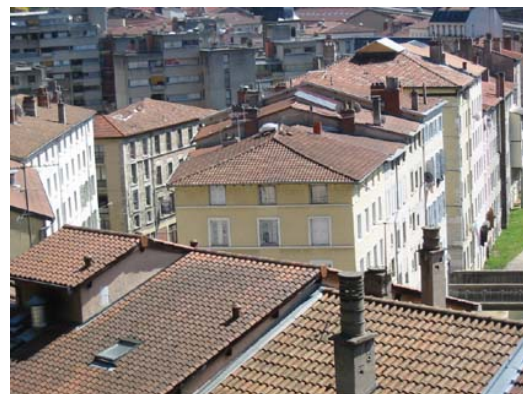
Toitures du quartier de la Gère. En arrière plan les toits terrasse des immeubles des années 70-80.
