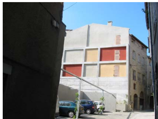
L'aménagement placette+stationnement a été accompagné d'un travail sur les pignons devenus apparents (ici façade de logement social consolidée avec nouvelles ouvertures) Romans, RHI îlot Folquet 2006
