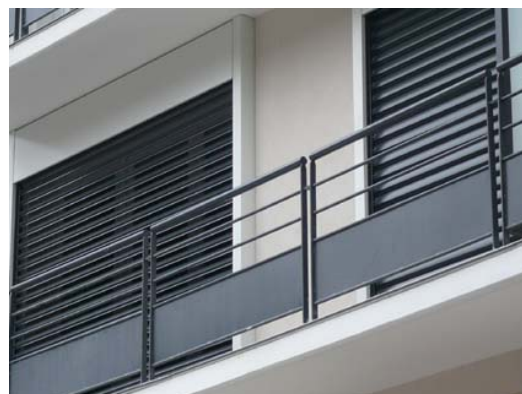
Stores lyonnais d'aujourd'hui, garde corps métallique sobre, Grenoble.
