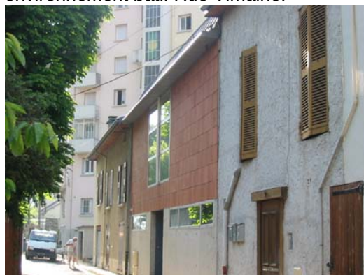
L'alignement et le gabarit restent identiques, aussi le style contemporain de cette maison s'intègre bien. Grenoble
