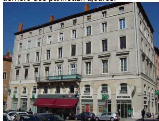
à éviter : la bâche continue qui « écrase » le rez de chaussée
