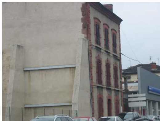
Eviter de donner à voir comme ici des façades et des espaces qui ne sont pas destinés à être vus.
