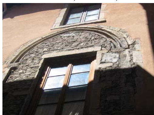
Baie ogivale bouchée (Rue de la Table Ronde)
