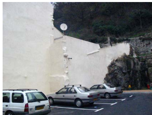
Eviter comme ici de donner à voir des façades et des espaces qui ne sont pas destinés à être vus. La rue pourrait être longée par un mur ou une haie et l'accès au parking limité à un porche. Rue Druge.
