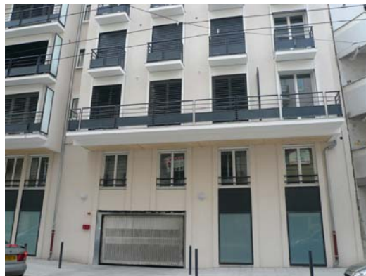
Accès au garage, immeuble récent (en cours de finition) Grenoble
