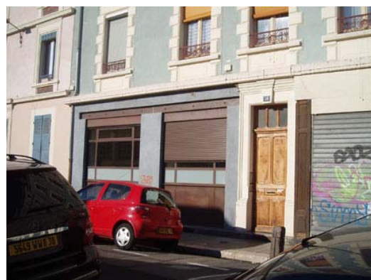
Bonne adaptation d'un atelier en logement
