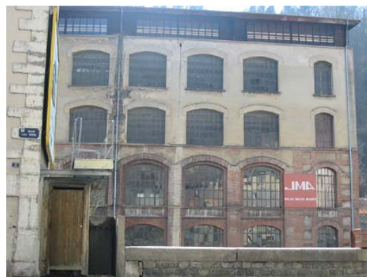
Surélévation d'une ancienne manufacture (limitée à un attique).
