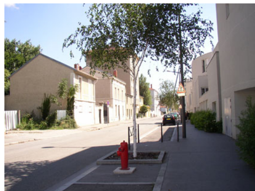
Lyon rue de Gerland. L'aménagement a redonné une unité à ce front bâti hétérogène et discontinu.
