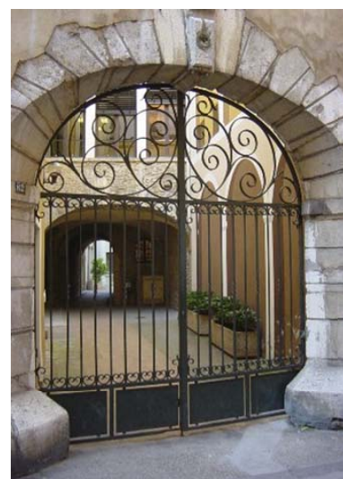
Ancienne entrée de l'hôtel de ville (Rue Marchande)
