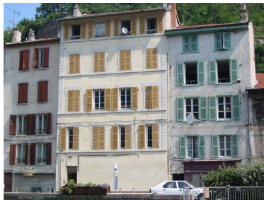
La mise en valeur de ces façades modestes s'appuie sur le rythme des volets, les partitions des vitrages, la modénature soulignée par la différence de traitement
