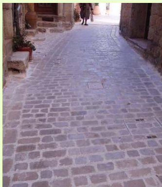
Pavés rejointoyés au mortier de chaux avec bandeaux latéraux
