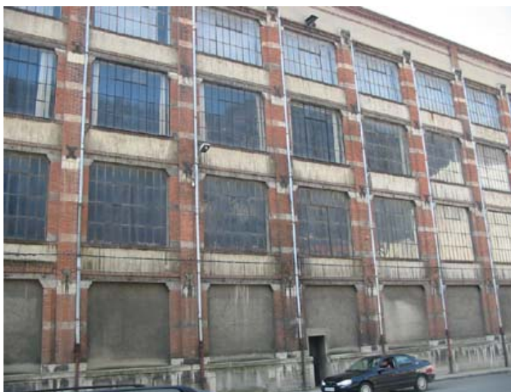
Ancienne usine, huisseries métalliques. Le maintien de la qualité des grandes ouvertures et de l'unité des façades est un enjeu majeur lors de la réhabilitation des bâtiments industriels.
