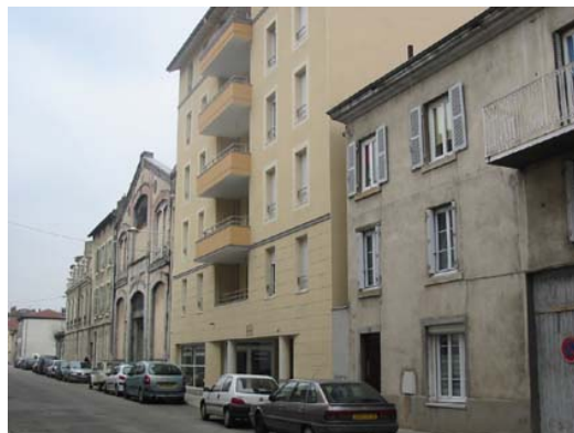
L'implantation de cet immeuble suit bien l'alignement de la rue mais sa hauteur est trop importante par rapport à son environnement bâti. Rue Vimaine.
