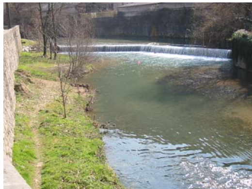
vue sur la Gère depuis la rue Lafayette
