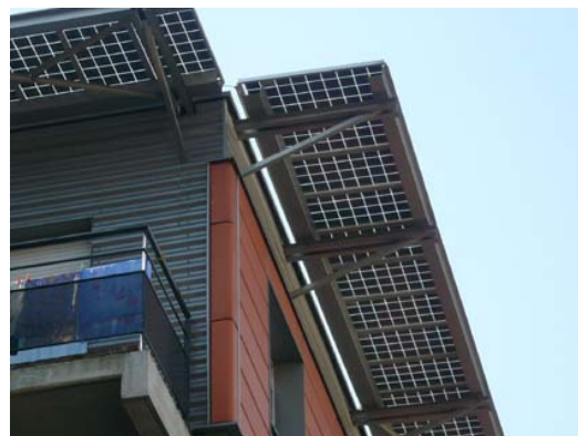
Pare-soleils avec cellules photovoltaïques sur toits terrasse, autorisé.
