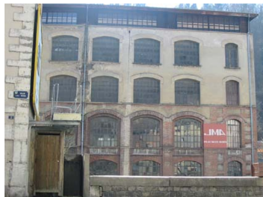
Surélévation d'une ancienne manufacture (attique). Vallée de la Gère
