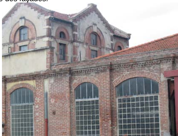
Usine Pascal Valluit, huisseries métalliques. Le maintien de la qualité des grandes ouvertures et de l'unité des façades est un enjeu majeur lors de la réhabilitation des bâtiments industriels.
