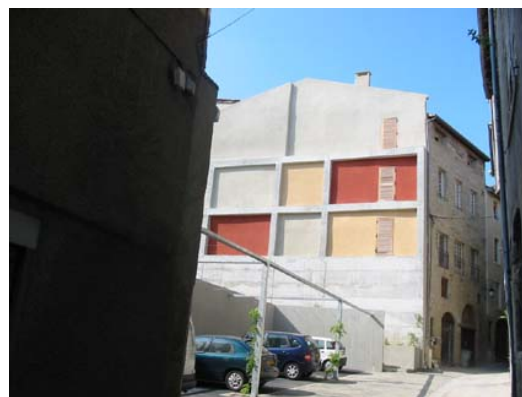
L'aménagement placette+stationnement a été accompagné d'un travail sur les pignons devenus apparents (ici façade de logement social consolidée avec nouvelles ouvertures) Romans, RHI îlot Folquet 2006
