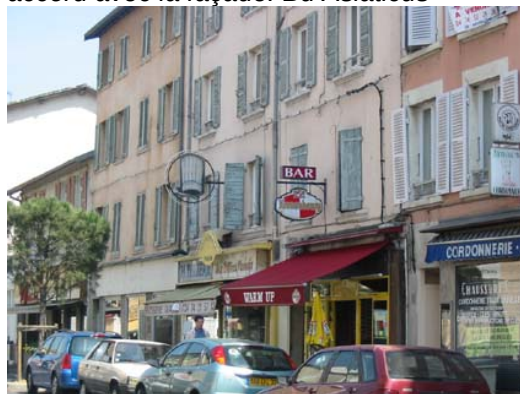
Cours de Verdun, le traitement des rez de chaussée perturbe la cohérence des façades.
