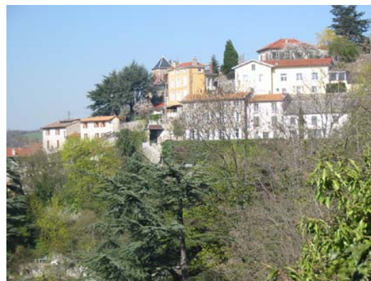
Collines Saint Gervais, toitures.
