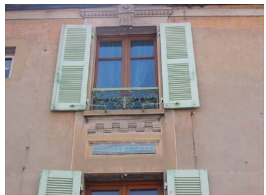
Fenêtres Bd Henri Fleury. Cette fenêtre dispose d'un joli garde corps en métal ouvragé.
