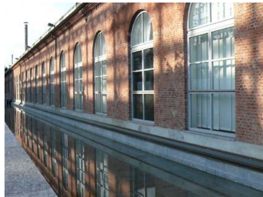
Turin, ancien arsenal réhabilité. Ouvertures de la salle de danse.
