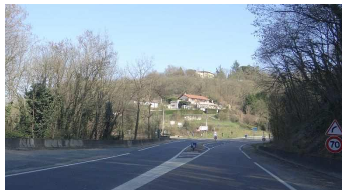
Entrée Est par la RD 41
