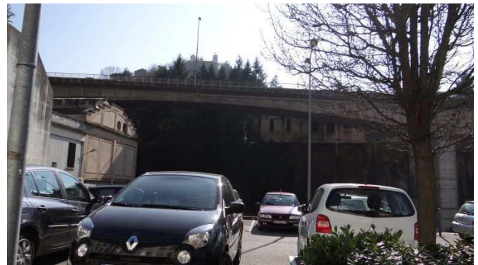
Impact visuel important du viaduc de la D41
