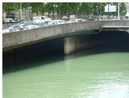
Passage en souterrain de la Gère
