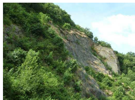
Falaise sécurisée dans le vallon de la Sévenne
