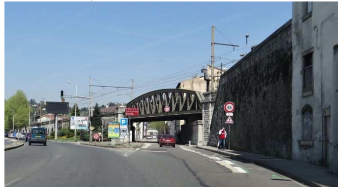
Carrefour Quai Pajot/Rue Bonnier
