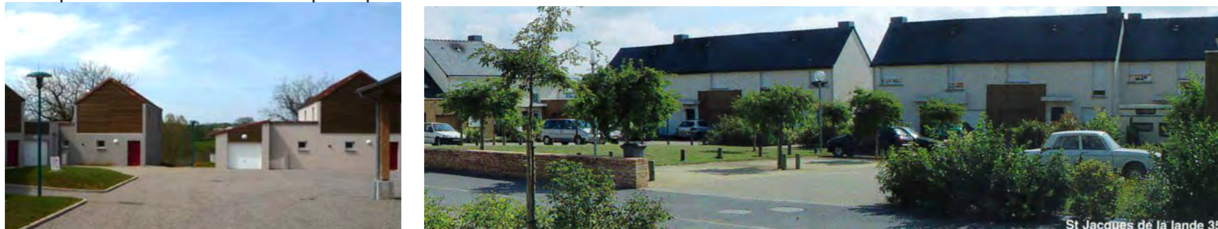
exemple de bâti structurant l'espace public ou commun
