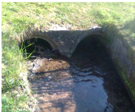
Figure 14. Buses presque entièrement colmatées sur la branche sud
