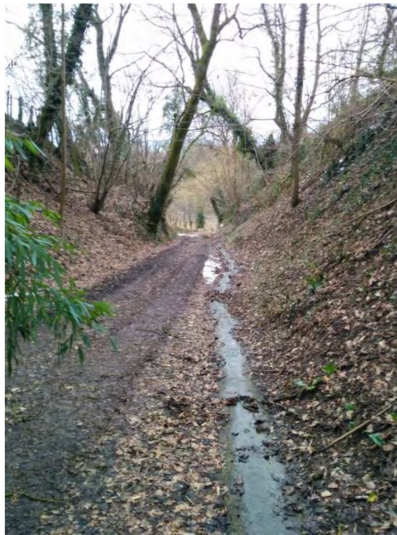
Figure 22. Cunette le long du Chemin du Grimaud à remplacer par une buse Ø400 ou un fossé en enrobé
