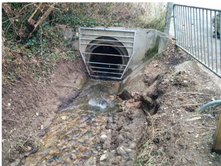
Figure 9. Grille à l'entrée de la buse Ø800 sous la RD1075
