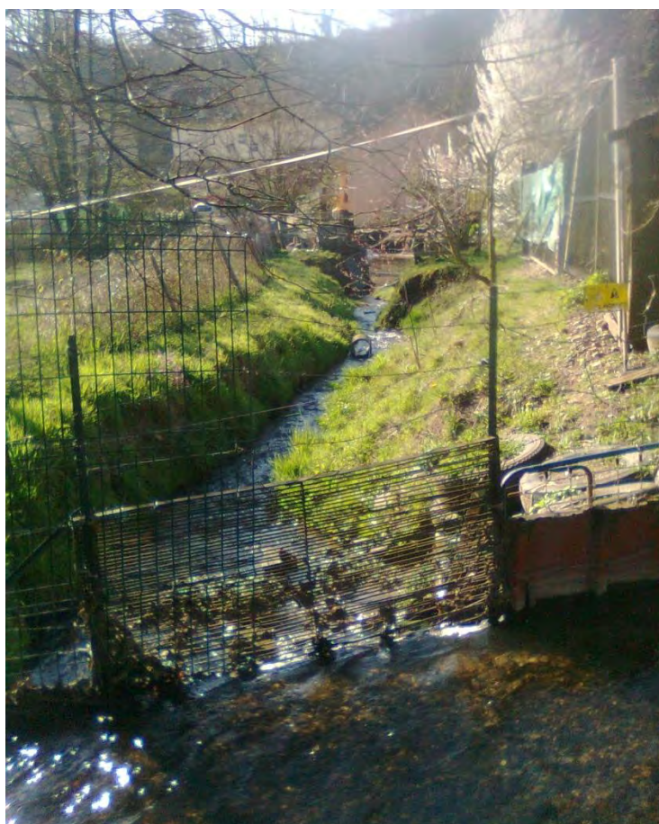
Figure 15. Ouvrage de régulation à la limite de deux bras du ruisseau des Moulins
