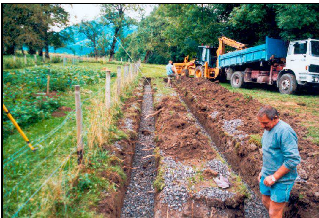
Tranchées d'épandage en cours de réalisation
