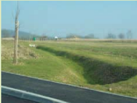
Noue de collecte de ruissellement diffus amont
