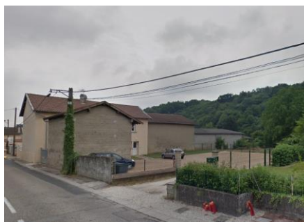
Bâti existant en limite de la route de Vienne (côté Ouest)
