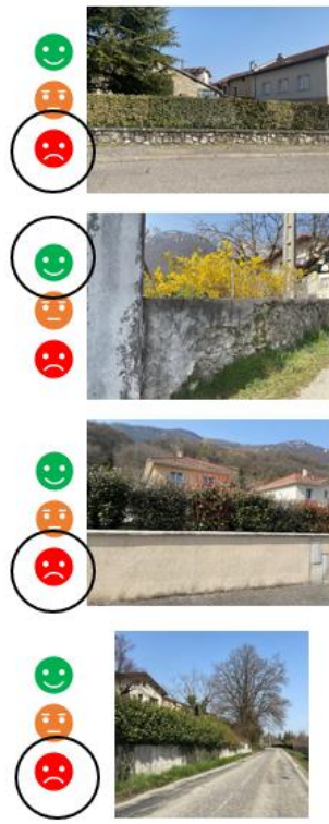
Mur bahut avec végétation
