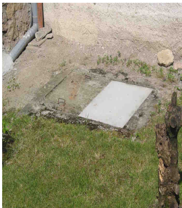
Regard de fosse septique et ruisseau dans lequel se rejettent les effluents prétraités
