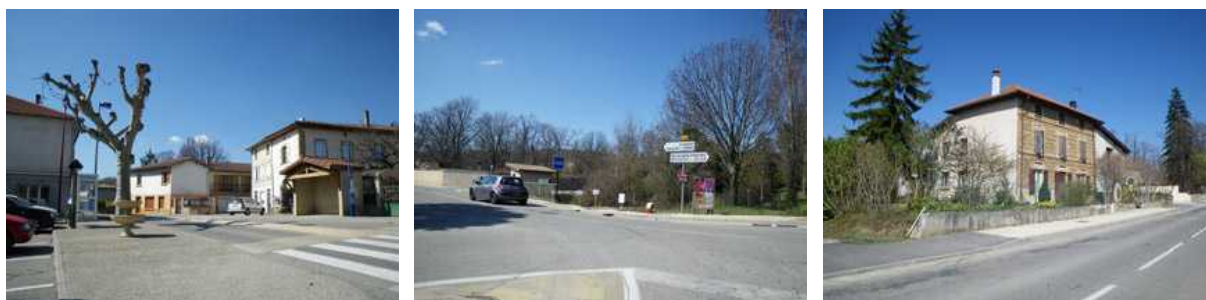
Aménagement et sécurisation de la RD 51 : dans le centre village, à l'intersection RD 51 et RD 51c et en entrée de village
