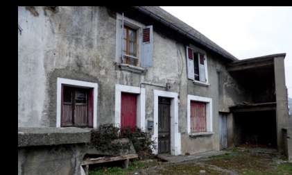
Vue sur le bâtiment communal en cours de démolition
