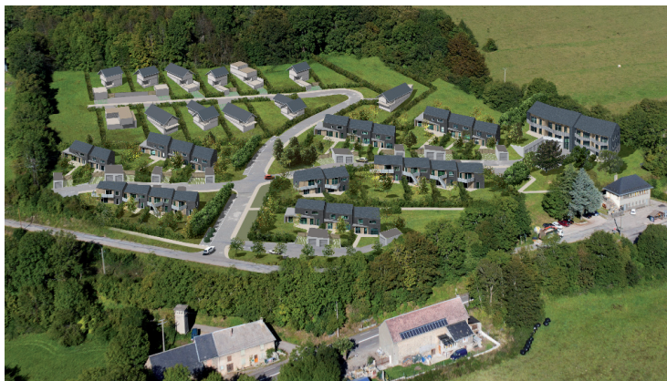
Projet des Eybains en cours de construction
