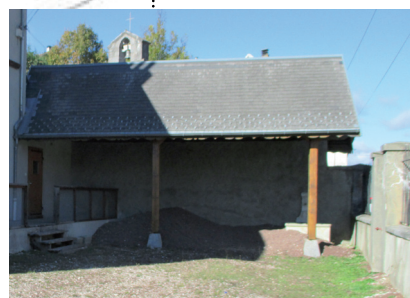
Préau à démolir
