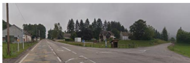
Absence de sécurisation des arrêts de bus
