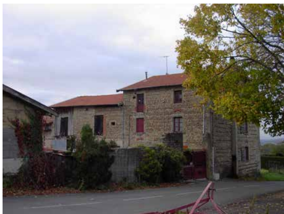
Bâti ancien et bâti récent
