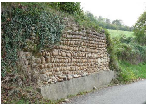
Mur traditionnel en galet au Canard
