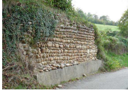
Mur traditionnel en galet au Canard
