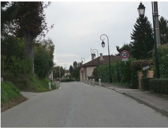
Traversée urbaine de la RD 134
