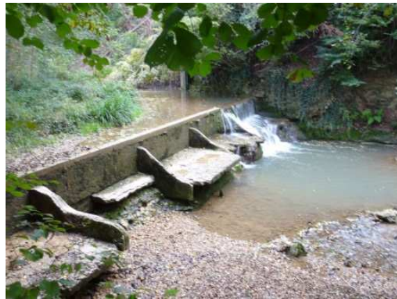
Seuil sur la Sanne au droit des équipements sportifs
