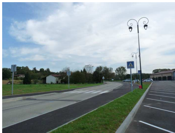
Aménagement de trottoirs le long de la RD 134
