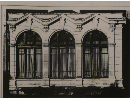
Fig. 97 : Les trois arcades de la façade Est de la salle de boules sont récupérées pour le projet.
