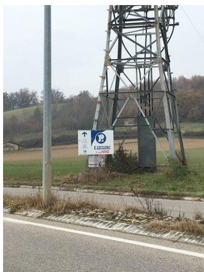
Publicité scellée, en forme de préenseigne (distance supérieure à 5 km) - Non conforme au RNP (support)
