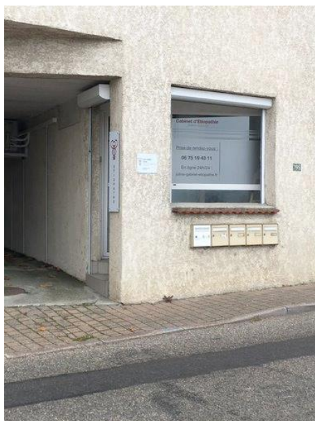
Cabinet - Ordonnancement de façade respecté - Enseigne murale apposée, vitrophanie occultante sur la totalité de la baie. Pose de petites enseignes sur pilier.
