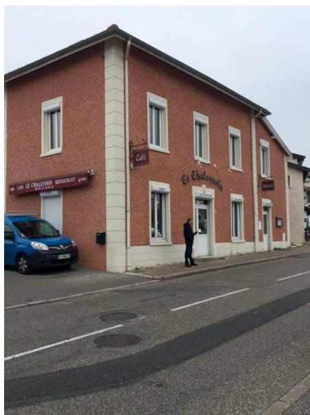
Restaurant - Volumétrie et ordonnancement de façade respecté - Enseigne murale apposée (lettres découpées), enseignes en drapeaux en retrait de l'angle du mur, sur store banne.
