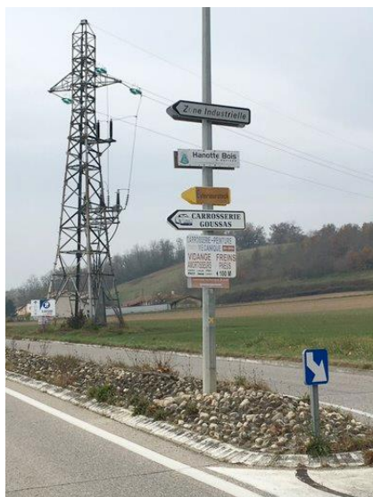
Préenseignes fixées sur mat éclairage public – Non conforme au RNP
