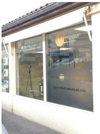
Local commercial – Vitrophanie qui couvre une partie importante de la baie.
