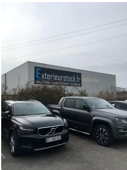
Enseigne murale – Rapport surfacique à vérifier
