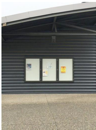
Panneaux d'affichage avec accès conditionné (vitrines) - Route du stade – Statut à clarifier
