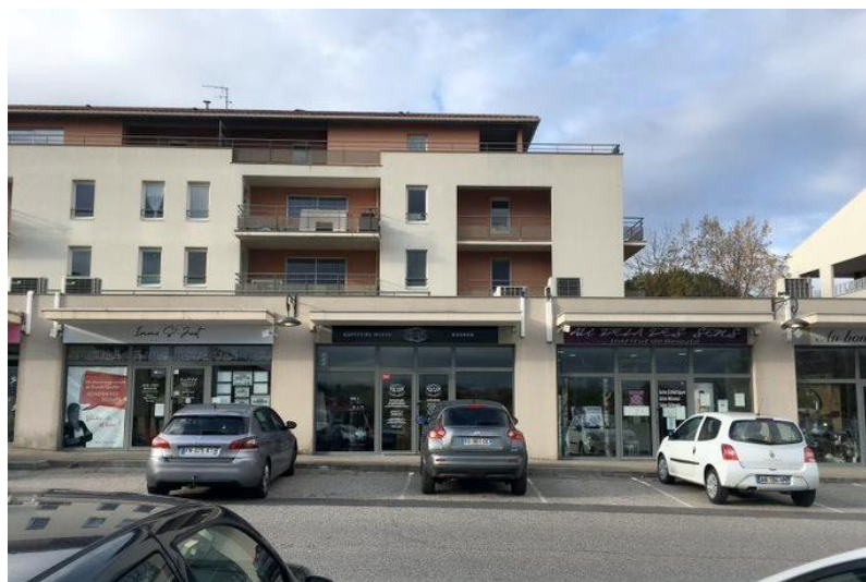
Locaux commerciaux - Enseignes murales éclairées, apposées en bandeaux au-dessus de chaque vitrine, vitrophanie partielle essentiellement pour les informations pratiques ; façade à gauche avec vitrophanie à caractère promotionnel couvrant une partie importante de la surface vitrée.
