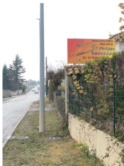
Publicité qui dépasse le mur qui la supporte - Non conforme au RNP (support) (en agglo)
