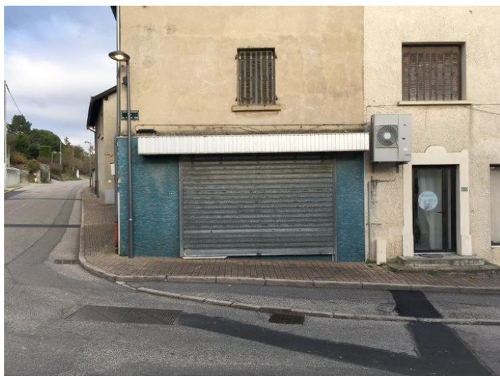
Local commercial vacant - RDC modifié pour ouvrir une large baie faisant vitrine - Le bandeau destiné à l'enseigne est en saillie par rapport à la façade et dépasse la largeur de la baie.
