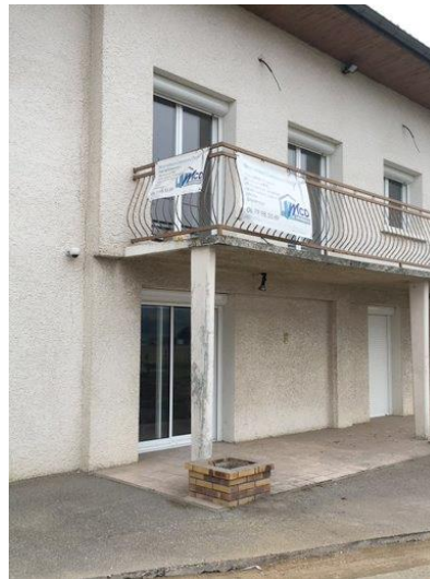
Pancarte publicitaire d'artisans en lien avec des chantiers en cours ou terminés (en agglo) RD36 – Non conforme au RNP (support)
