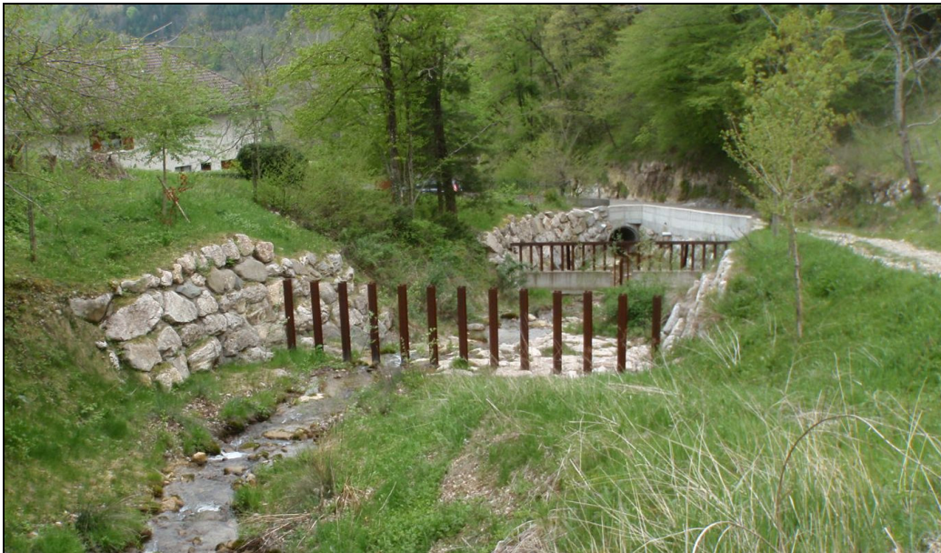
Figure 10 : Vue de l'amont des travaux récents d'aménagement du ruisseau de Pierrefit (RTM 38 - 2014)
