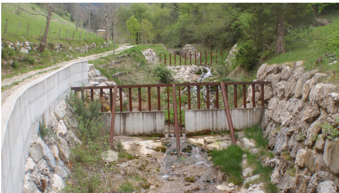
Figure 27 : Travaux de piège à embâcles et de recalibrage du lit du ruisseau de Pierrefit à l'amont du centre village (RTM 38 - 2014)
