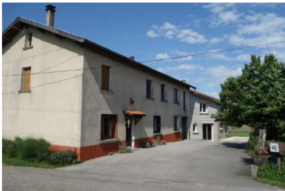
Vue du sud-ouest, depuis la route
