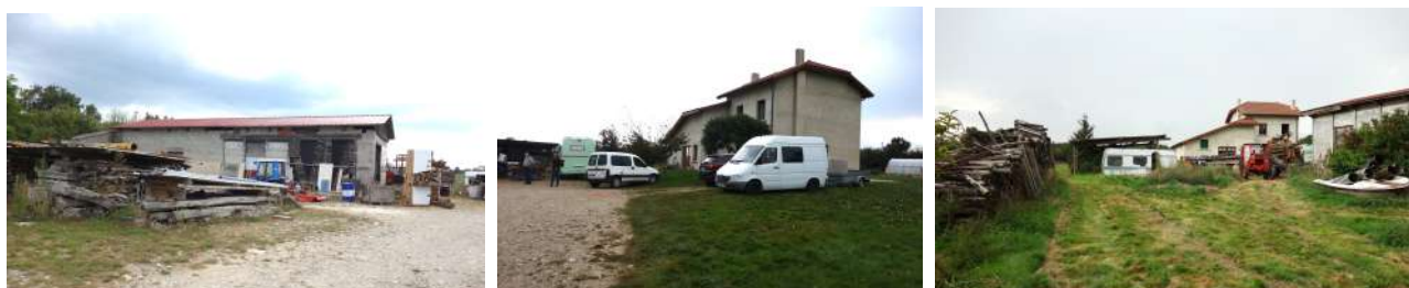
Les constructions sur le site : à gauche, l'atelier ; au centre, l'habitation existante ; à droite, un hangar métallique au fond du terrain.
