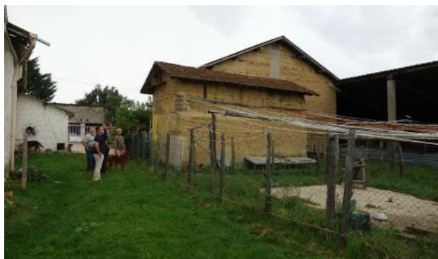
Arrière de la grange au nord
