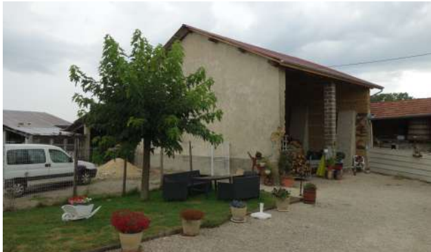
Angle sud de la grange
