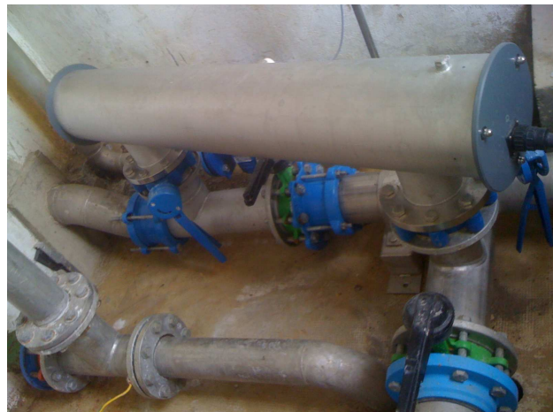
Réservoir principal : Vue extérieure et traitement UV
