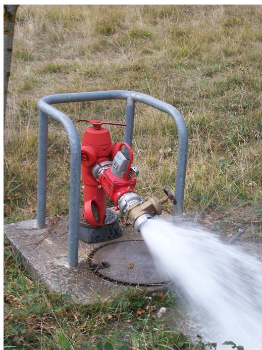
Mesure d'un poteau incendie
