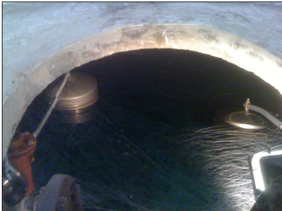
De gauche à droite : flotteur de l'alimentation principale, flotteur de l'alimentation de secours
