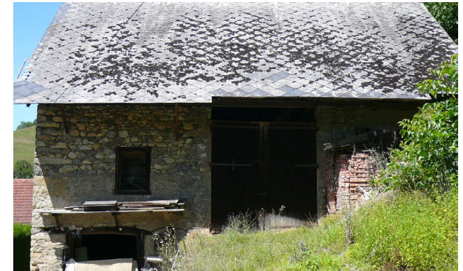
Toit 2 pans, débordant largement
