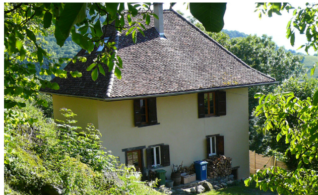
Toit 4 pans, faitage court, tuiles écailles
