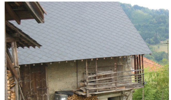
Galerie abritée par l'avancée de toit
