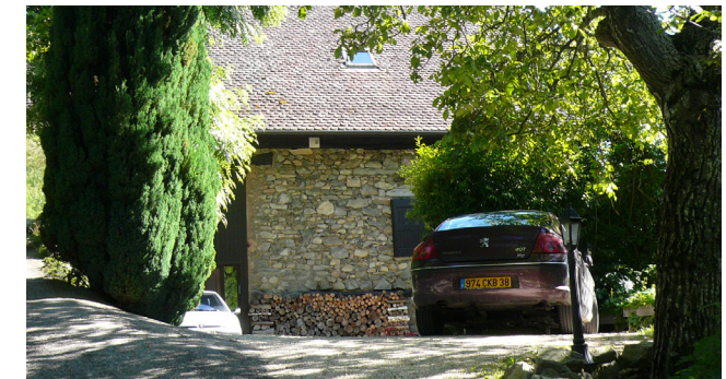
Accès à niveau
