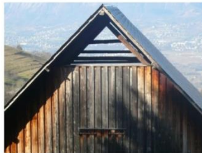
Pignon refait, partiellement ouvert. Le Rif
