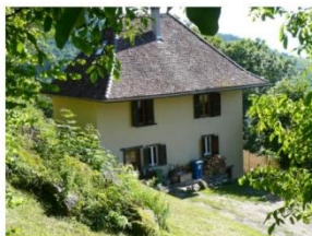
Toit de tuiles écailles, pente forte adoucie en bas de versant par un coyau. L'Eglise
