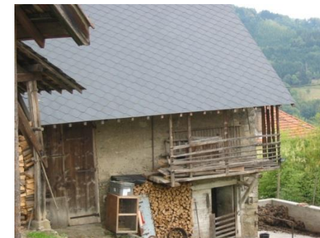
Galerie abritée par l'avancée de toit
