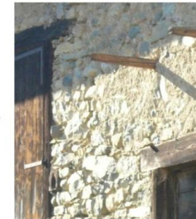
Murs en pierres locales, l'enduit apparaît encore par endroits
