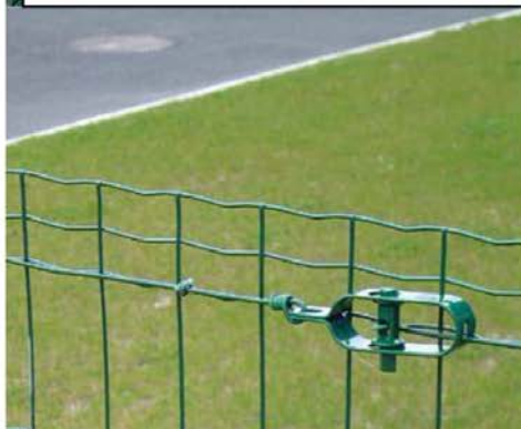
Grillage semi-rigide électrosoudés à mailles
