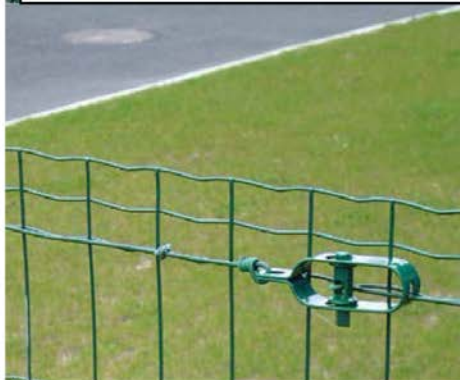
Grillage semi-rigide électrosoudés à mailles
