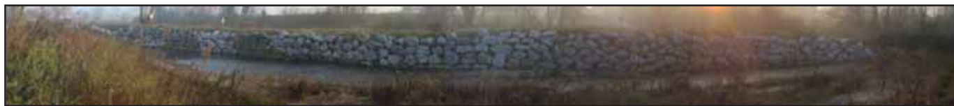
Confortement de berge en enrochements secs
