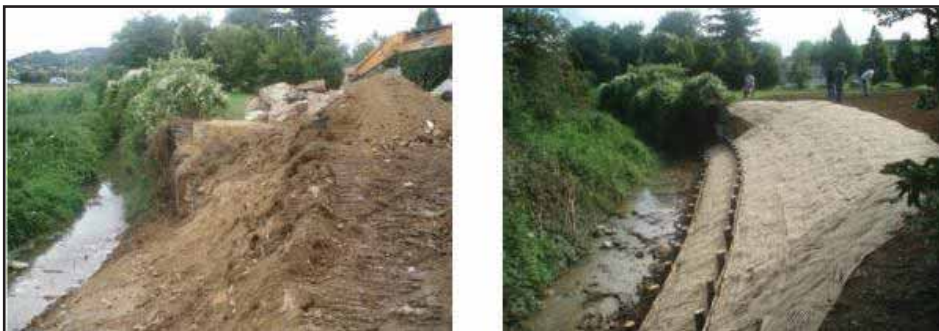
Stabilisation de berge par pieux et géotextiles
