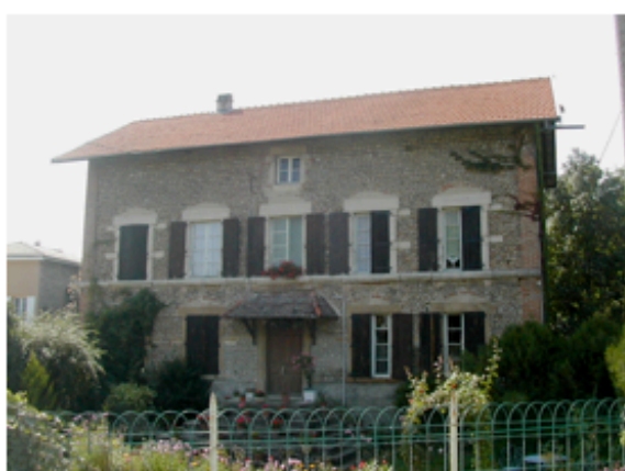
Maison, La Goutériat
