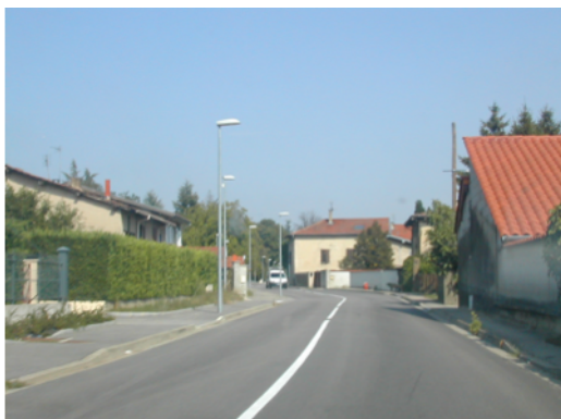
Trottoirs bilatéraux le long de la RD 519
