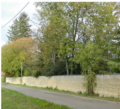
Mur en pisé à la Goutériat
