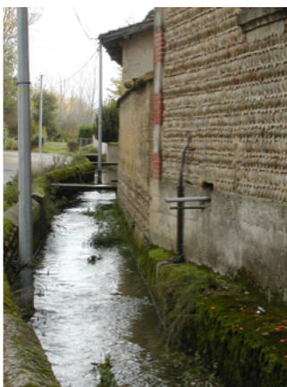
Canal à la Goutériat
