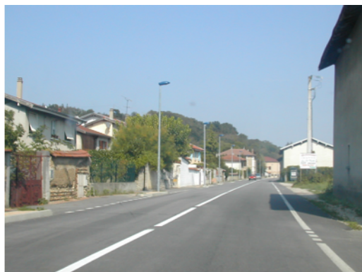
Trottoirs discontinus le long de la RD 519
