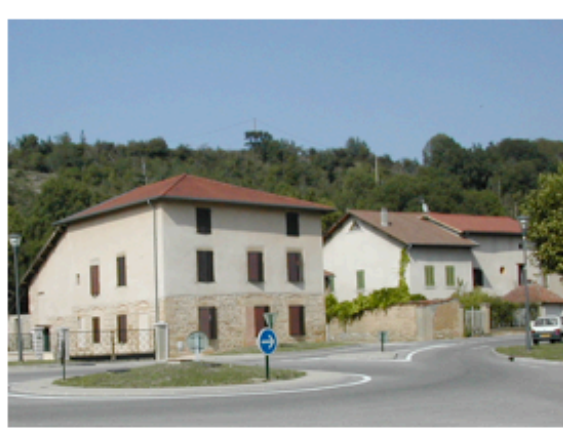
Maison de village, en bordure de la RD
