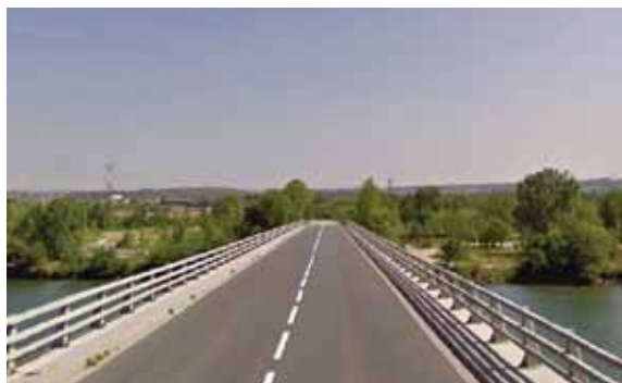
Entrée Ouest sur la RD37b
