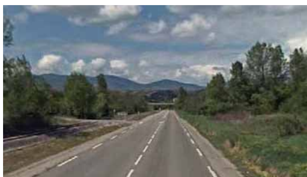
Entrée Est sur la RD37b
