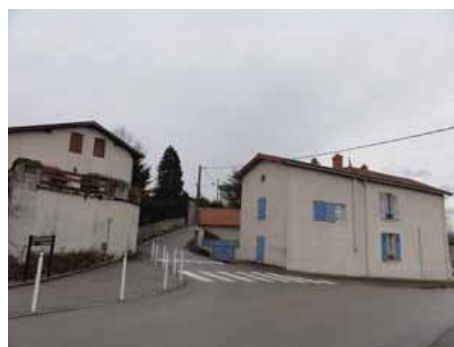
Maisons rurales anciennes rue des Révolets et Chemin des Crêts
