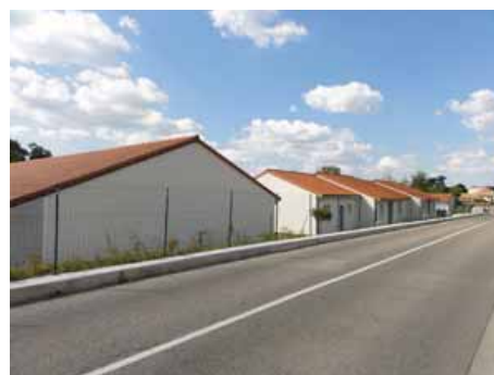
Maisons groupées Coquelicots et résidence La Varèze
