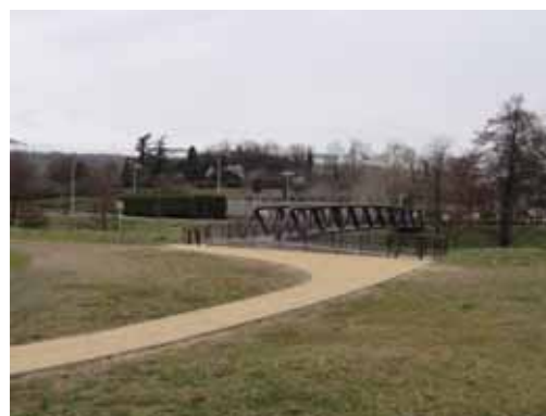
Passerelle piétonne de la Varèze
