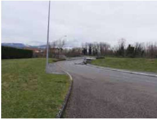
Le pont reliant le secteur du Tural au centre-village
