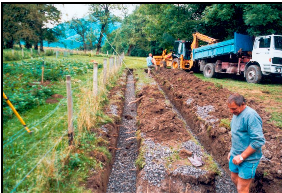
Tranchées d'épandage en cours de réalisation
